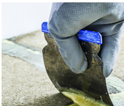
Répartir le produit régulièrement pour combler la fissure
