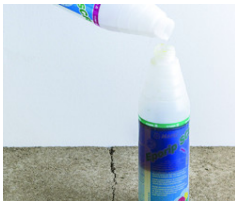
Le composant A est versé dans le flacon du composant B
