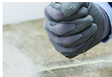
Sabler à l'aide de Quarzo 1,2 ou de sable propre sur le support encore frais comme pont d'adhérence pour les couches suivantes
